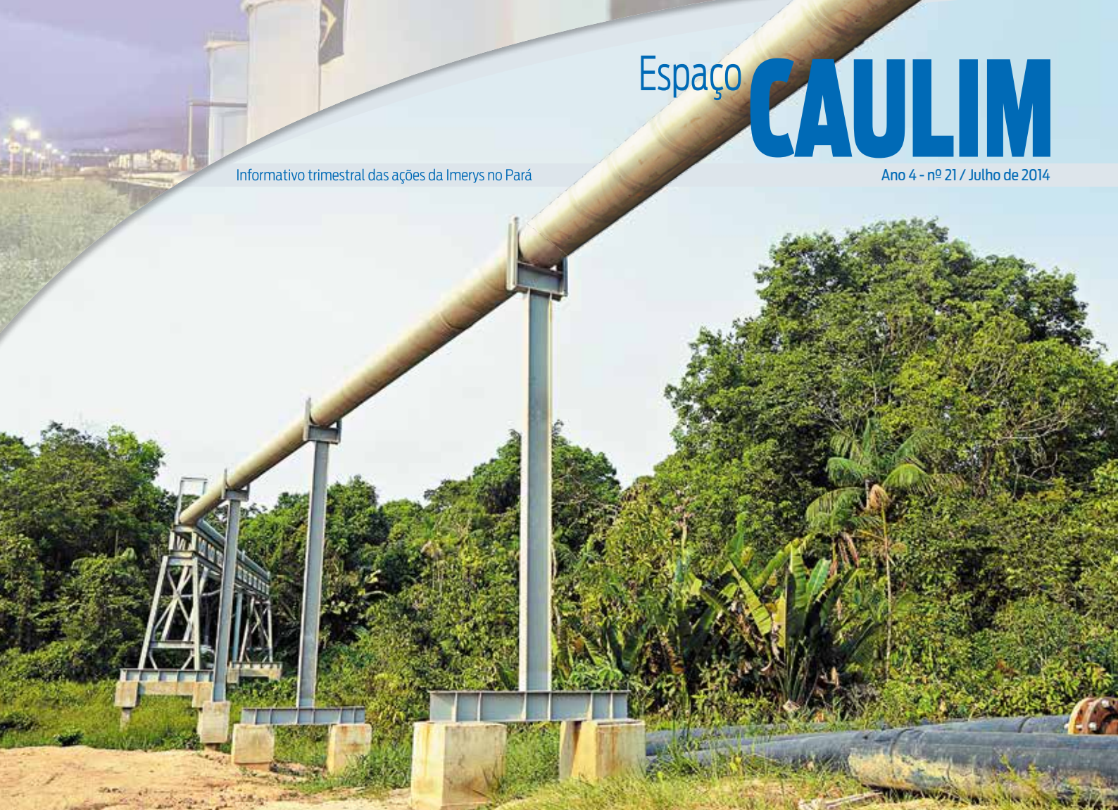
Instalação de pórtico metálico elevou tubulações e reforçou segurança em igarapé de Barcarena (PA)
